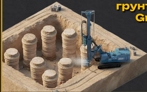
Устройство буриабивных и буринъекционных свай
